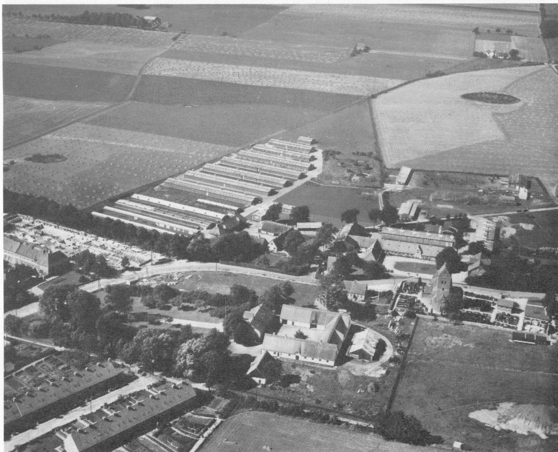
Kirkehavegård i forgrunden, tv. Lillerød Skole hvor grunden er ved at blive gravet ud til 1952-fløjen. Langs denne
